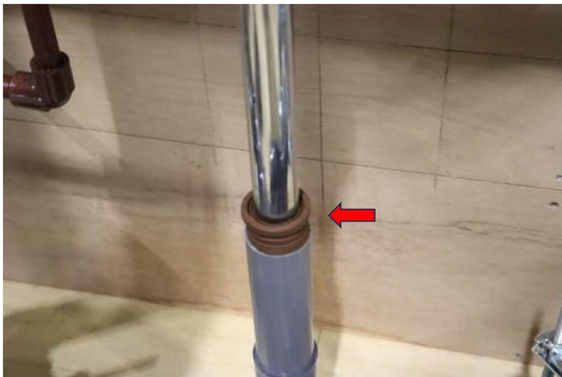
通気管 減点事例：通気管の取り出し位置の誤り。
