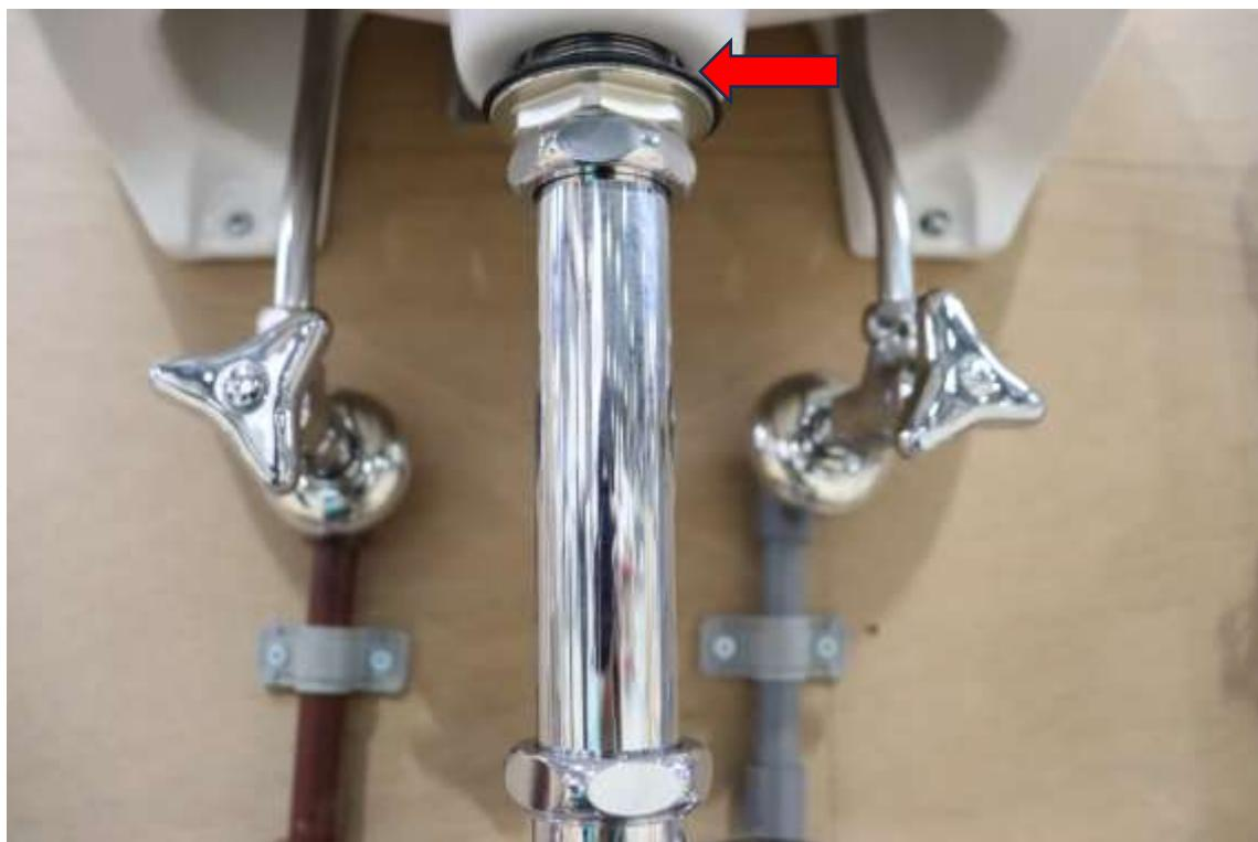
洗面器 減点事例：使用するネジが適切でない（1）（参考資料（2）参照）。
