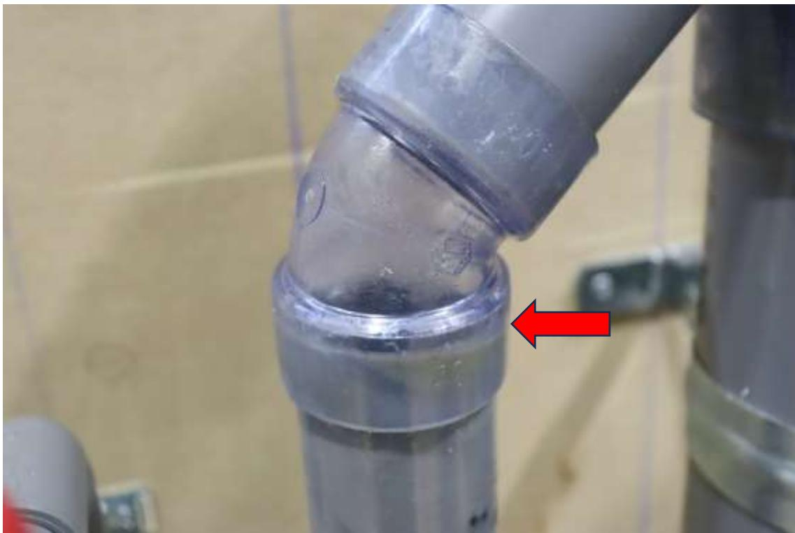
塩化ビニル管 減点事例：差し込み不良、接着剤の塗りすぎ。
