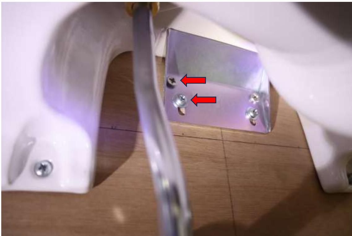
洗面器 減点事例：使用するネジが適切でない（4）（参考資料（2）参照）。
