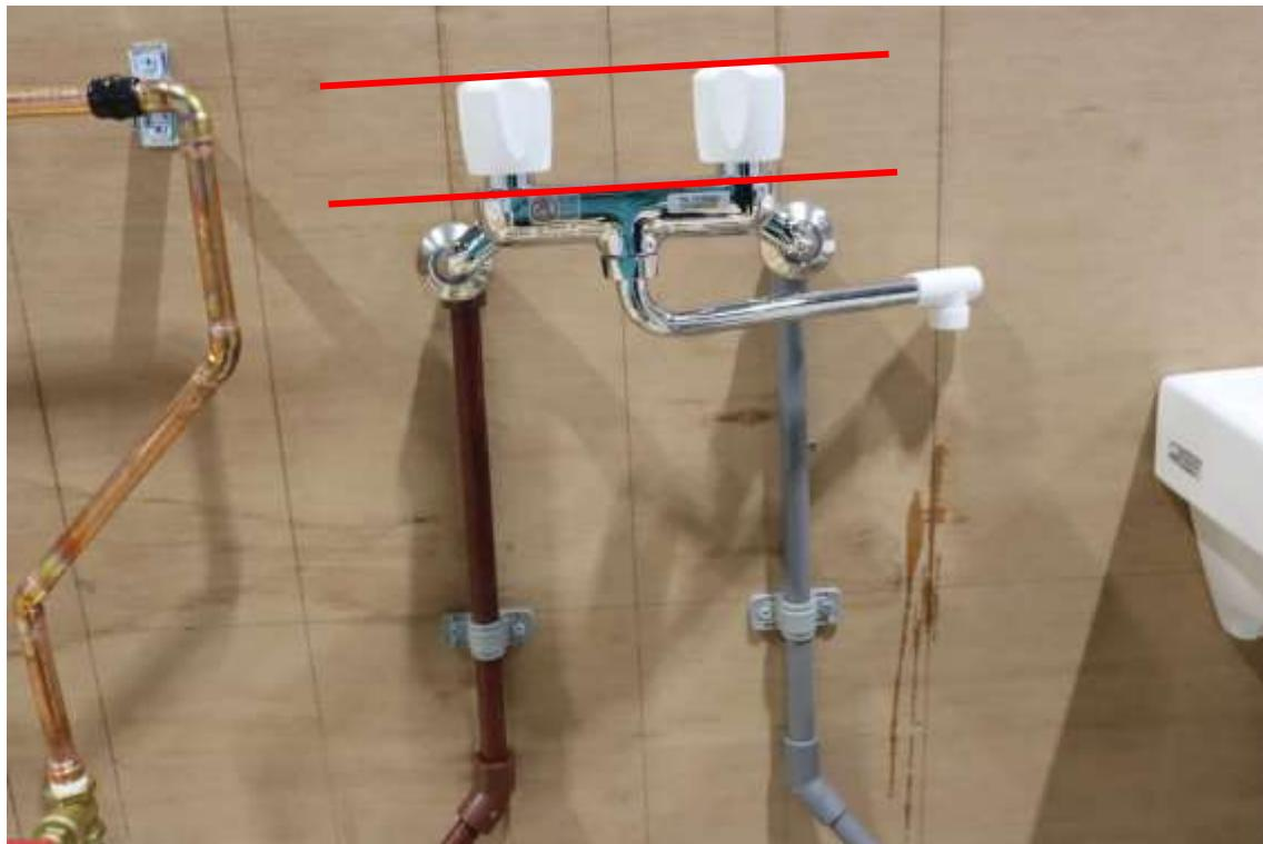
その他 減点事例：材料確認した後、梱包をほどいて蛇口、止水栓、トラップなどのメッキ製品をひとまとめに養生せずケースに入れている。また、器具類やメッキ金物類は、傷が付くと品質に影響するので、取付直前まで包装は外さないこと。
