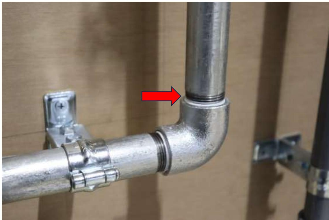
钢管 減点事例：ネジ加工の不良（残りネジ山の不足）。
