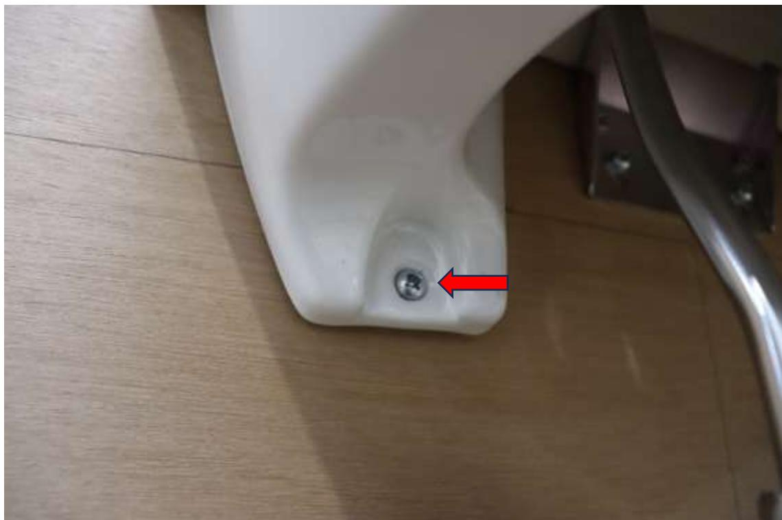
洗面器 減点事例：使用するネジが適切でない（3）（参考資料（2）参照）。
