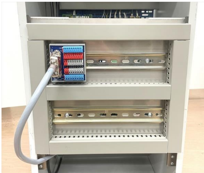
図 2 新規 sta.アッセンブリボード持ち込み状態
