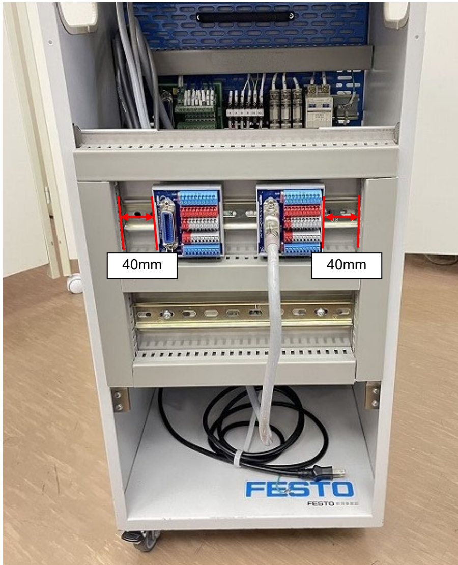
図 2 新規 sta.アッセンブリボードの取付状態
