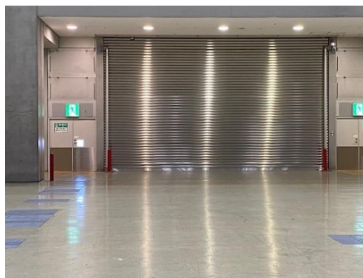
【図 4】荷物搬入口
