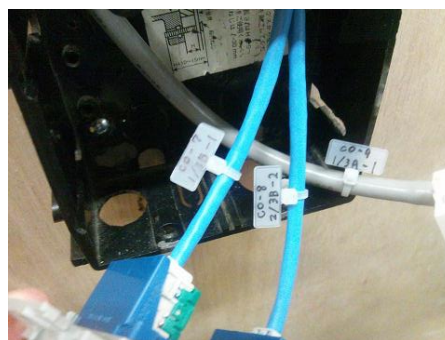
(c) ボックス内のケーブルへのラベル 例 : [A/ 3C-1]
