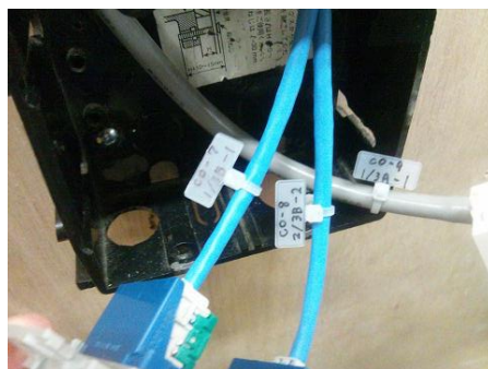
(c) ボックス内のケーブルへのラベル 例 : [A/ 3C-1]
